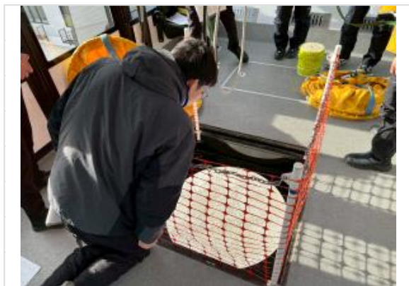
防護柵の設置
