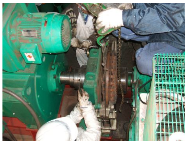
主減速機取り外し作業
