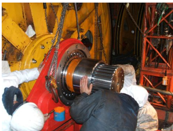
原動滑車軸交換作業
